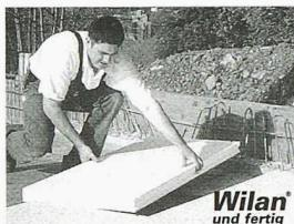
Isolationselemente **einseitig** belegt mit äußerst widerstandsfähigen Fertigdeckschichten aus Kunststoffen, Faserzement oder Holzwerkstoffplatten. Für das direkte Einlegen und einbetonieren in Deckenschalungen oder für nachträgliche Montagen.
