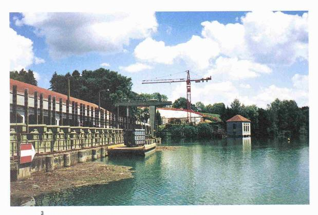
Oberwasserseitige Ansicht: links Maschinenhaus, Mitte und rechts hinten die Baustelle mit dem bleibenden Einlaufturm
