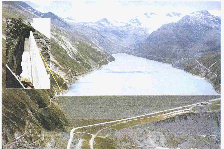
Stauanlage Mattmark mit Hochwasserentlastung
