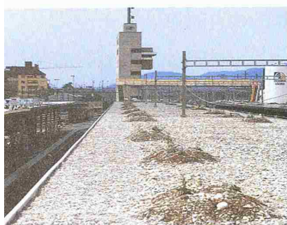
Reliefartige Dachbegrünung im HB Zürich
