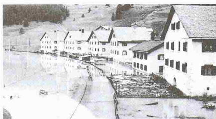
Überschwemmung des Quartiers Ariefa im südöstlichen Teil von Samedan 1951 (Bilder: pd)
