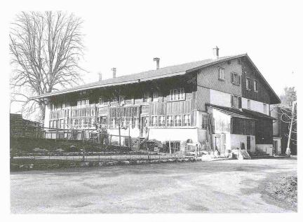
Der Flarz in Ruetschberg am linken Ufer des Pfäffikersees (ZH) entstand zur Hauptsache durch Umnutzungen und Teilungen eines um 1533 erstellten Vielzweckbaus. Von den vier quer zum First ausgeschiedenen Wohnteilen sind zwei zusätzlich firstparallel geteilt (Bild aus Band 2 der Reihe «Die Bauernhäuser des Kantons Zürich»)
