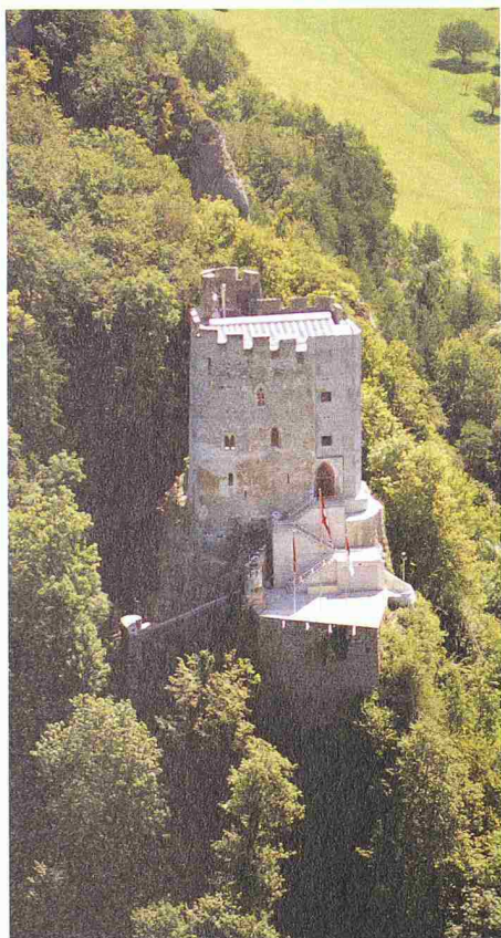
Die Ruine Neu-Thierstein nach der Sanierung. Erkennbar sind die in Beton ausgeführte «Füllung» der eingestürzten Ecke sowie das neu eingezogene Dach
