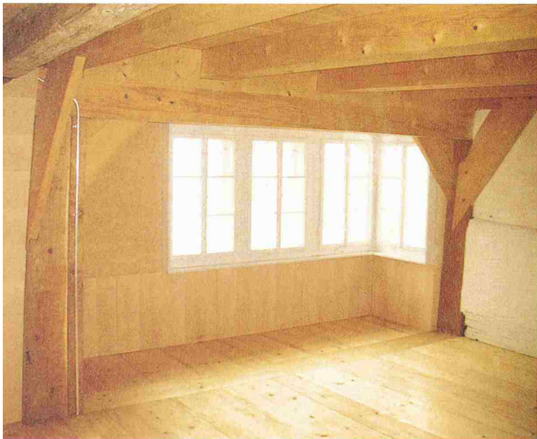
8, 9 und 10 Treppenhaus, Eckfensterdetail und Wohnraum, nach der Sanierung
