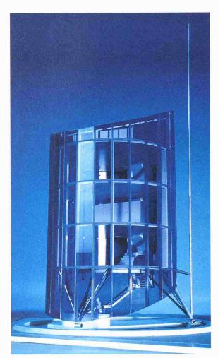
hochdämmende Paneele von nur 50 mm Dicke. Ein beweglicher Sonnenschutz-Schirm richtet sich selbstaktiv nach dem Sonnenlauf, seine vertikalen Lamellen bewegen sich nach einer anderen Regel, wonach der Sonnenschutz die Transparenz nicht beeinträchtigen darf. Über den genauen Mechanismus gibt ein zusätzliches Modell 1:5 Auskunft. Auf dem Prüfstand der hausund gebäudetechnischen Simulationsprogramme kann in dieser Kombination neuer Ansätze der Passivhausstandard in Leichtbauweise erreicht werden.
