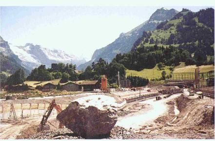
Bau der offenen Interventionsstelle bei Frutigen. Bei Unfällen erleichtert die in einem offenen Graben anstatt durchgehend im Tunnel geführte Strecke den Zugang zur Unfallstelle (Bilder: Zoppet)
