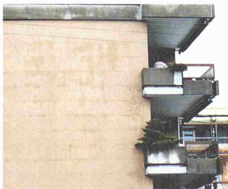
Die Plattenstösse beginnen sich nach einer gewissen Zeit auf der Fassade abzuzeichnen. Neu Streichen der Fassade bringt nur kurzfristig Abhilfe
