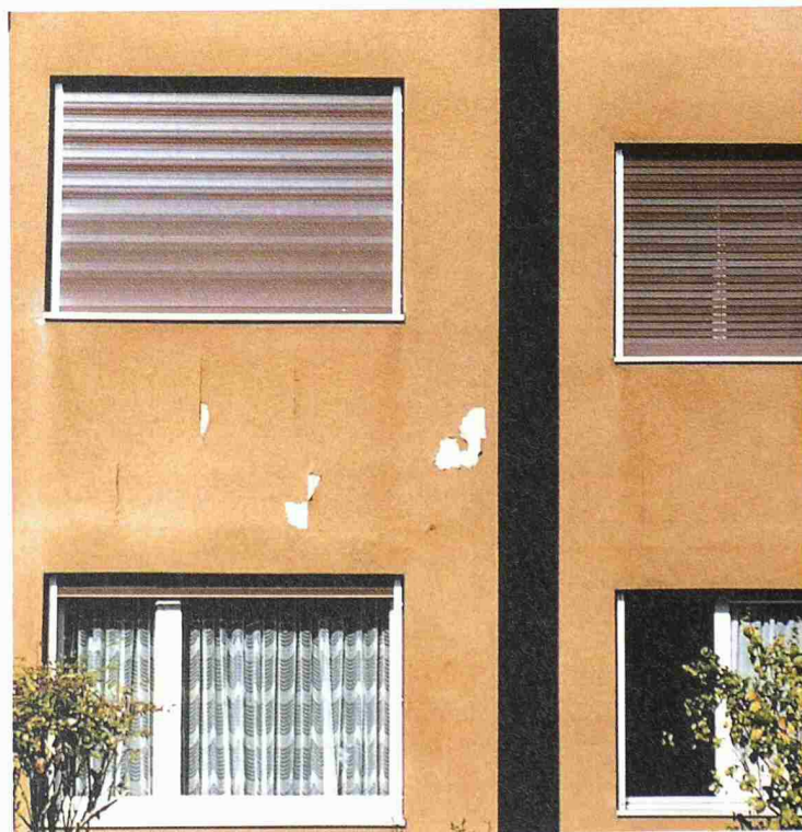
Risse in der Fassade führen durch eindringendes Wasser zu Abplatzungen des Verputzes
