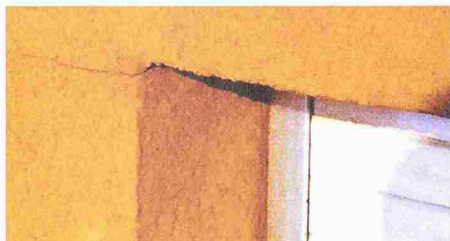
Spannungsriiss an Sturzecke
