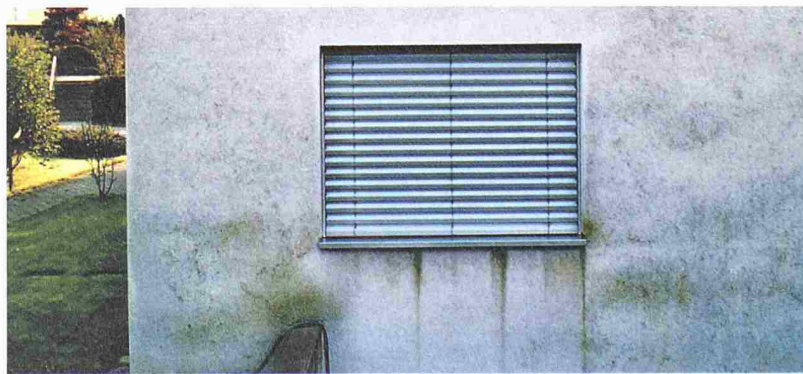
Algen und Pilzbewuchs gilt seit einigen Jahren als Mangel, der beanstandet werden kann
