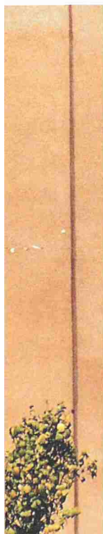
Spannungsriiss an Sturzecke
