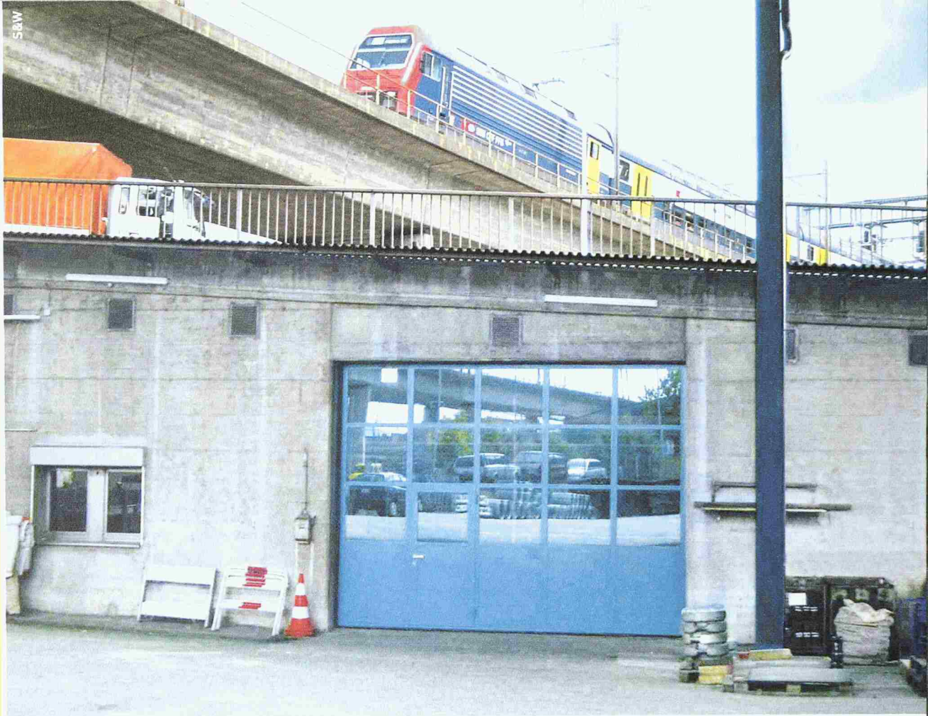
Sika-Produkte und ihre Anwendung beim nachträglichen Toreinbau an der Duttweilerbrücke Zürich
