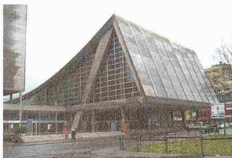
Das Bieler Kongresshaus nach der Sanierung 2002. Oberes Bild: verglaste Fassade des Hallenbades (Bilder: Georg Fischer AG)
