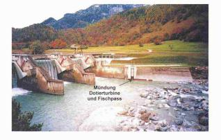
7 Detailansicht des Schlitzpasses unterer Abschnitt (Bauherr: Patvag Kraftwerke AG). Höhenunterschied: 12,0 m; Länge: 185 m, Gefälle: 6,5 %, Breite: 2,1m, Abfluss: 0,525 m³/s, Anzahl Becken: 59 (Bild: Rolf-Jürgen Gebler)
