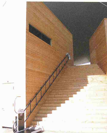
Der Treppenlift «Rigert-Pegasus» erschliesst gehbehinderten Menschen die Piazza Pinocchio auf der Arteplage Neuenburg
