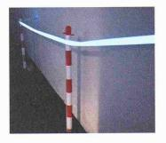
zu 200 m. Die Leuchtstreifen werden in Dottikon (AG) produziert und sind in verschiedenen Breiten (12,5-250 mm) und Farben erhältlich. Nach der Laminierung zwischen zwei spritzwasserfesten, auf Wunsch flammhemmenden, umweltverträglichen und strapazierbaren Schutzfolien sind die Bänder nur ca. 0,6 mm dick, verbrauchen lediglich 100-150 Watt
