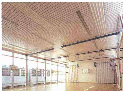
Deckenstrahlplatten von Zehnder; Einsatzbereich in Räumen bis 30 m Höhe
