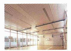
Deckenstrahlplatten von Zehnder: Einsatzbereich in Räumen bis 30 m Höhe
