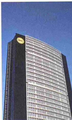
5 Arag Versicherung in Düsseldorf, 1994–2000 erbaut, von RKW mit Foster und Partnern (Bild: A. Compagno)
