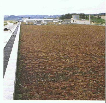
Bei zu luftigen Mischungen fliesst das Regenwasser zu rasch ab. Der erwünschte Wasserrückhalt wird nicht erreicht, und es entwickelt sich eine Monokultur aus Sedum. Bei zu leichten Substraten besteht zudem die Gefahr der Winderosion.
