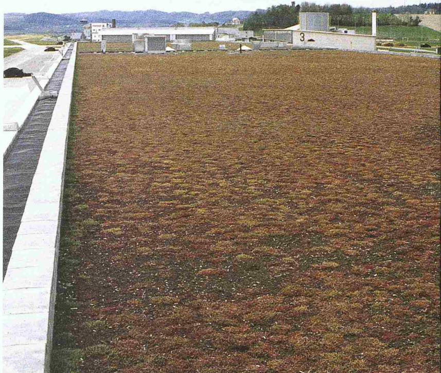
Bei zu luftigen Mischungen fliesst das Regenwasser zu rasch ab. Der erwünschte Wasserrückhalt wird nicht erreicht, und es entwickelt sich eine Monokultur aus Sedum. Bei zu leichten Substraten besteht zudem die Gefahr der Winderosion.
