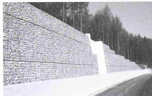
Böschung- sicherung am Baregg A1
