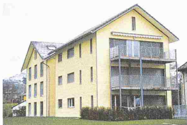
Überbauung Ziel in Appenzell; Fassade: System Outdoor-Top
