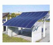
gesetzt werden. Die Solarmodule eignen sich für Dachkonstruktionen aus Holz, Metall oder Beton und bilden eine dichte Dachhaut. Die Halterungen der Solar-Freestyle-Elemente sind kompatibel mit solarthermischen Elementen, was eine einfache Kombination beider Technologien ermöglicht. Der gewonnene Strom kann wahlweise gegen Vergütung jeder Kilowattstunde in ein Stromnetz eingespeist werden oder Teile des hauseigenen Verbrauchs decken. Granit Systems SA
