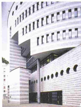
Eingangsbereich mit Schleuderbetonstützen; Botha-Haus, UBS in Basel (Bild: Varinorm)
