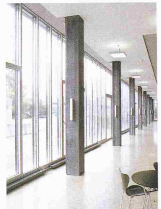
Die filigranen Stützen fördern die Transparenz des Gebäudes; Interkantonales Technikum Rapperswil (Bild: Varinorm)
