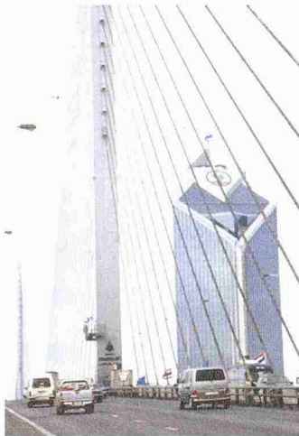
Untersuchte RAMA-IX-Brücke in Bangkok, Thailand
