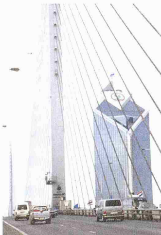
Untersuchte RAMA-IX-Brücke in Bangkok, Thailand
