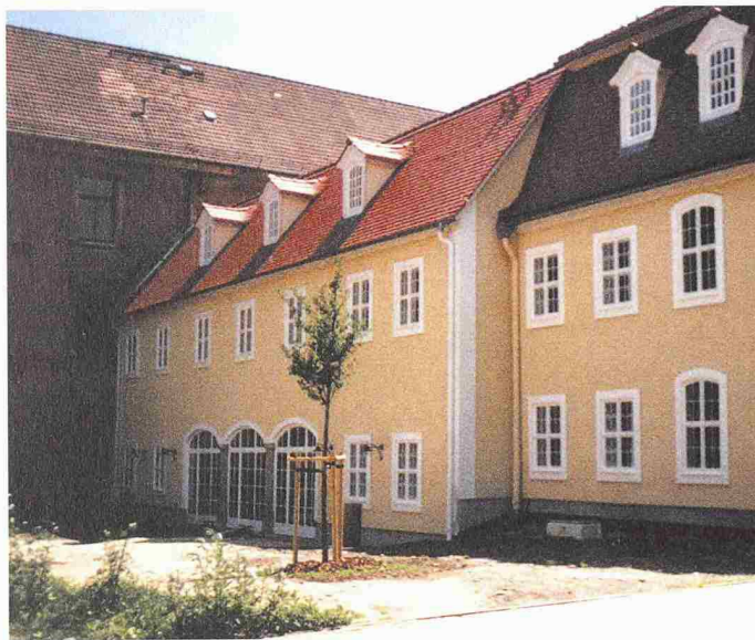
So wie das hintere Gebäude sah die Bibliothek in Niesky vor der Sanierung aus. Wärmegedämmt und mit denkmalgerechten Wärmeschutzfenstern präsentiert es sich heute (Bild: P. J. Landfried GmbH, Kamenz)
