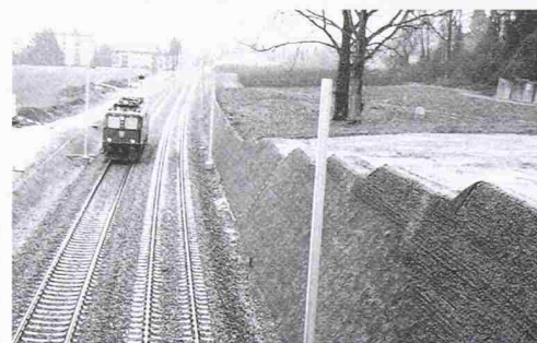
60° Steilböschung neue Doppelspur MThB Kreuzlingen.
