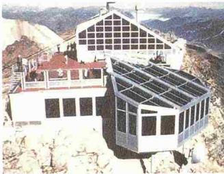
Netzgekoppelte 4,35-kW-PV-Anlage an der Gipfelstation der Rothornbahn (Lenzerheide). Die Generatoren in einem warmen gelbbraunen Farbton sind transluzid
