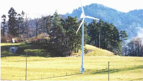
2/3 Leichtwindanlage mit einer 6-kW-Turbine in Oberhelfenschwil. Nabenhöhe 18 Meter. Rotordurchmesser 13 Meter. Durchschnittliche Jahresproduktion: 15 MWh (Bild: Aventa)
