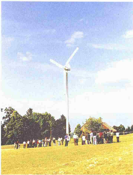
Leichtwindanlage mit einer 6-kW-Turbine in Oberhelfenschwil. Nabenhöhe 18 Meter. Rotordurchmesser 13 Meter. Durchschnittliche Jahresproduktion: 15 MWh (Bild: Aventa)
