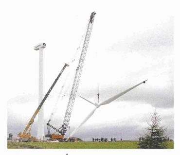
Montage des Rotors an einer 850-kW-Turbine auf dem Mont-Crosin. Nabenhöhe: 50 Meter. Rotordurchmesser: 52 Meter. Geschätzte Jahresproduktion: 900 MWh (Bild: Juvent)
