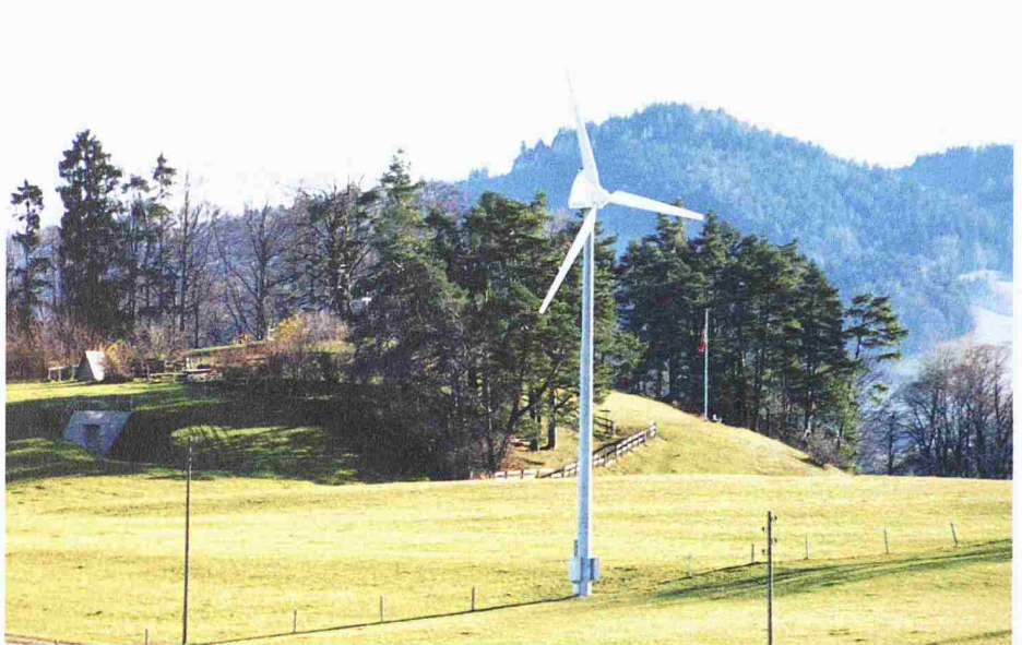
Leichtwindanlage mit einer 6-kW-Turbine in Oberhelfenschwil. Nabenhöhe 18 Meter. Rotordurchmesser 13 Meter. Durchschnittliche Jahresproduktion: 15 MWh (Bild: Aventa)
