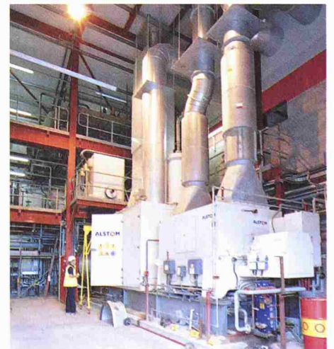
Im Innern des Biomassekraftwerkes: die Gasturbine (Bild: First Renewables Ltd.)
