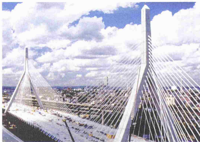
Die breiteste Schrägseilbrücke der Welt über den Charles River in Boston, USA. Seilführung in der mittleren Spannweite am Fahrbahnrand, in den Aussenfeldern mittig (Bild: Francis und Imelda Murphy)
