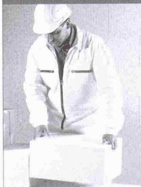
Durch Grifftaschen und das geringe Gewicht ist der PORIT Stein besonders handlich, lässt sich leicht heben und versetzen. PORIT hat ein Doppel-Nut und Feder-Profil. Die Steine können passgenau versetzt werden. Sie sparen sich die Stossfugenvermörtelung und damit Zeit. PORIT ist massiv, kann jedoch leicht gesägt und bearbeitet werden. Leitungsschlüsse werden gefräst, Schalterdosen gebohrt.
