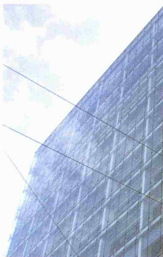
Das Mobimo-Hochhaus in Zürich: Tageslichtnutzung als Teil eines Gesamtenergiekonzepts (Bild: pd)
