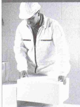
Durch Grifftaschen und das geringe Gewicht ist der PORIT Stein besonders handlich, lässt sich leicht heben und versetzen. PORIT hat ein Doppel-Nut und Feder-Profil. Die Steine können passgenau versetzt werden. Sie sparen sich die Stoßfugenvermörtelung und damit Zeit. PORIT ist massiv, kann jedoch leicht gesägt und bearbeitet werden. Leitungsschlitzte werden gefräst, Schalterdosen gebohrt.
