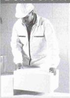
Durch Grifftaschen und das geringe Gewicht ist der PORIT Stein besonders handlich, lässt sich leicht heben und versetzen. PORIT hat ein Doppel-Nut und Feder-Profil. Die Steine können passgenau versetzt werden. Sie sparen sich die Stossfugenvermörtelung und damit Zeit. PORIT ist massiv, kann jedoch leicht gesägt und bearbeitet werden. Leitungsschlitze werden gefräst, Schalterdosen gebohrt.
