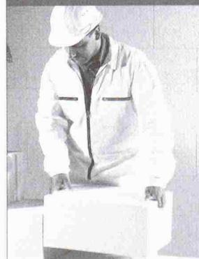
Durch Grifftaschen und das geringe Gewicht ist der PORIT Stein besonders handlich, lässt sich leicht heben und versetzen. PORIT hat ein Doppel-Nut und Feder-Profil. Die Steine können passgenau versetzt werden. Sie sparen sich die Stossfugenvermörtelung und damit Zeit. PORIT ist massiv, kann jedoch leicht gesägt und bearbeitet werden. Leitungsschlüsse werden gefräst, Schalterdosen gebohrt.
