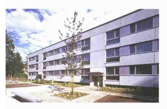
Alle ehemals hellgrauen Kittfugen wurden neu schwarz eingebracht, um das Bild der Elementbauweise noch zu verstärken. Der positive Nebeneffekt dieser dunklen Fugen ist, dass eine erneute Verschmutzung nicht mehr sichtbar sein wird. Mit dem Ersetzen der weiss gestrichenen Holzfenster durch dunkelgraue Metallfenster entstand ein starker Kontrast zu den hellen Betonplatten. Wenn bei Tageslicht die Fensterbänder dunkel erscheinen, wird so die horizontale Schichtung des Fassadenbildes hervorgehoben.
