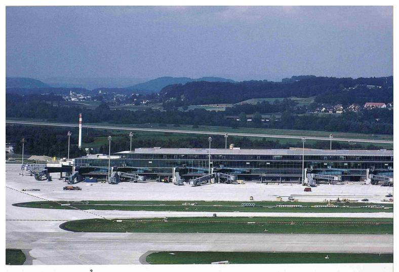
Der 500 Meter lange Bau hat sechs Promille Neigung: ein Vollgeschoss Höhenunterschied, unsichtbar (Bild: Comet, Dieter Enz)
