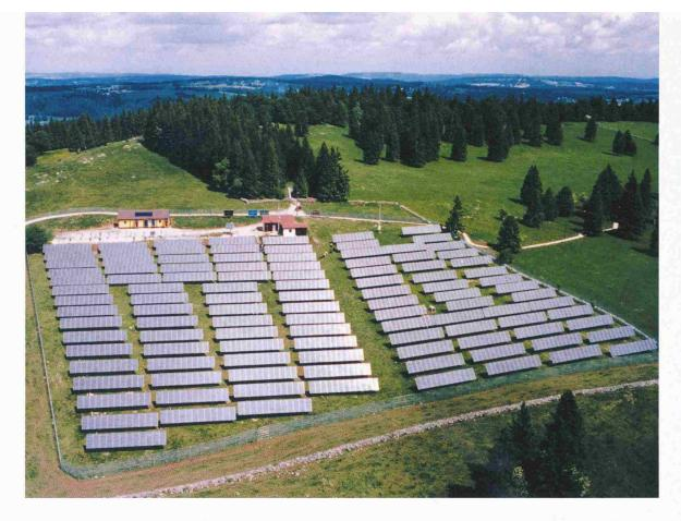
Photovoltaikpark Mont-Soleil: Schafe leben innerhalb der Anlage und halten die Vegetation in Schach. Damit verhindert man, dass die Paneele überwuchert werden (Bild: BKW FMB Energie AG)
