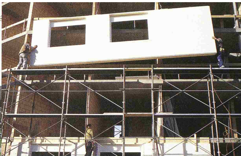
Mehrfamilienhaus in Jona (Architekt H. Oberholzer). Das Gebäude wurde in Mischbauweise erstellt, hat einen massiven Kern und ein Holzleichtbau-System als Fassade mit Schutzfunktion
