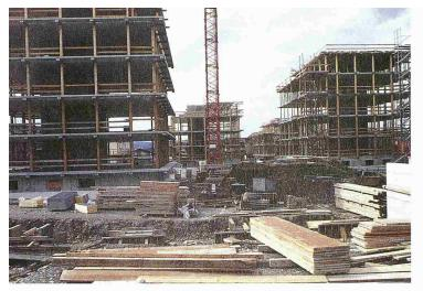
3 Mehrfamilienhaus in Uster (A. Streich AG, Architekten S. Hubacher und Chr. Haerle). Der als «Balance» bekannte Mischbau besteht aus einem massiven Kern und einem Holzleichtbau-System als Fassade mit tragender und schützender Funktion
