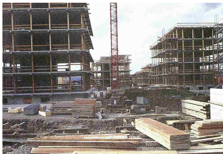
Mehrfamilienhaus in Uster (A. Streich AG, Architekten S. Hubacher und Chr. Haerle). Der als «Balance» bekannte Mischbau besteht aus einem massiven Kern und einem Holzleichtbau-System als Fassade mit tragender und schützender Funktion
