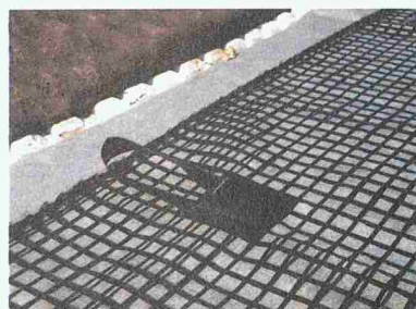
Auf Drainageschicht und Filtervlies wird das «Fallnet» flächig ausgebreitet. Die Kunststoffschlaufen dienen als Anschlagpunkte für das Sicherheitsgeschirr des Dachgärtners
