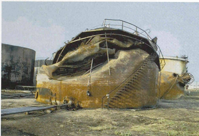
Tankanlage mit Folgebrand nach dem verheerenden Erdbeben vom 17. 8. 1999 bei Izmit, Türkei (Bild: pd / Erkundungsmission der Schweizer Gesellschaft für Erdbebeningenieurwesen und Baudynamik, SGEB)
