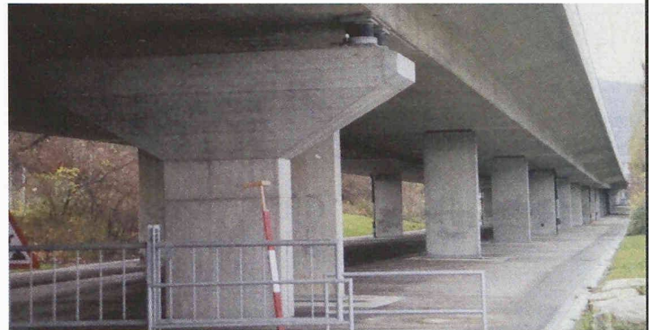
Schwimmend gelagerte Brücke: Europabrücke Zürich (Bild: M. Wieland)
