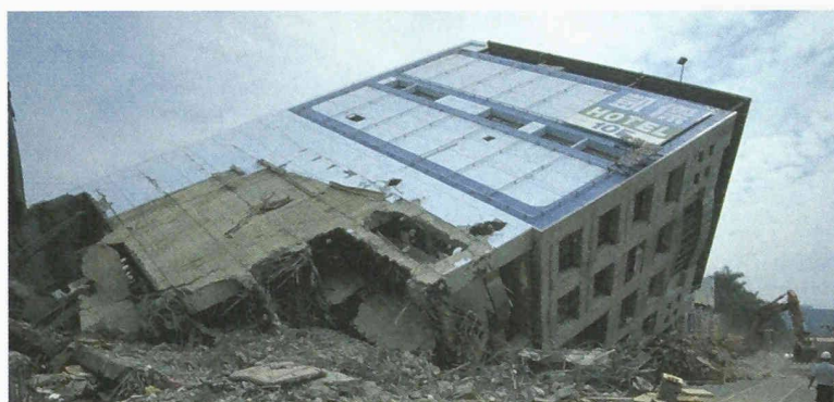
5 und 6 Zerstörte Gebäude in Taiwan (Bild: T. Wenk)
