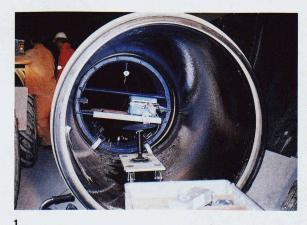
Einzelverbindungsprüfung der Steinzeugrohre vor dem Betonieren
