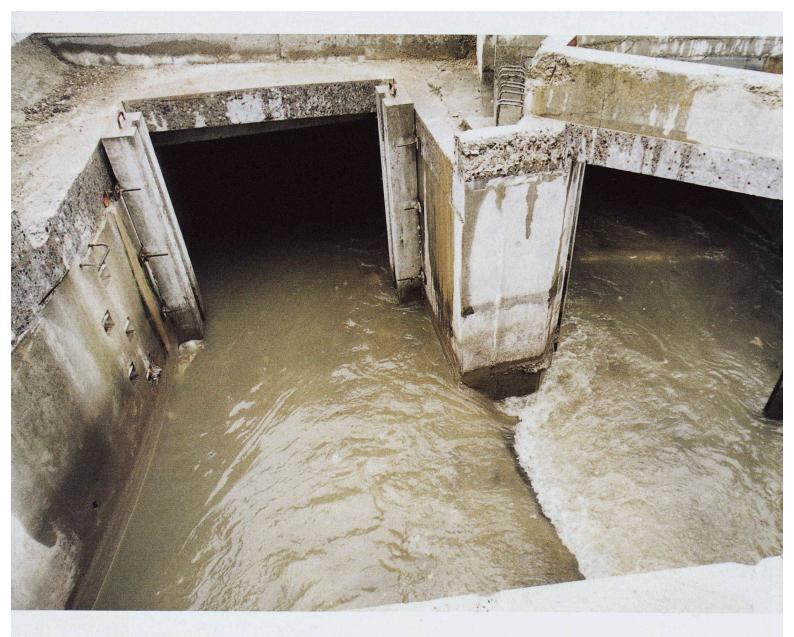
2 Aufteilung des Abwassers im Zulaufkanal während des Probebetriebs. Links der Zulauf zum Klärwerk Glatt, rechts derjenige zum Überleitungsstollen
