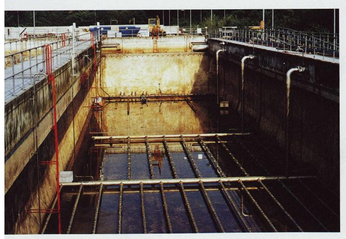
300 Belüfterdomen empfohlen. Gleichzeitig zu den Nachrüstungsmassnahmen wurden sämtliche bestehenden 18 000 Belüfterdome durch neue ersetzt (Bild 2). Mit einer einheitlichen Bestückung können unterschiedliche Druckverluste vermieden und der Energieverbrauch positiv beeinflusst werden. Neben den Keramikdomen wurden aus korrosionstechnischen Gründen die bestehenden Belüfterteller durch abwasserbeständige Chromstahlteller ersetzt.
