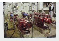
Kaltschlammpumpen fördern den Schlamm zu den Wärmetauschern
