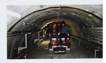
Bahnhofs Oerlikon in den Stollen. Damit die komplexe Logistik der Anlieferung und Verteilung des Materials von Anfang an reibungslos funktionierte, wurde der mit der Verlegung der Abwasserrohre betraute Unternehmer mit der Materialverteilung beauftragt. Diese Arbeitsgruppe hatte sich beim Ausbau der unteren Querschnittshälfte mit der Stollenlogistik befasst und war somit in der Lage, die Materialverteilung ab Beginn der Stolleninstallationenen effizient durchzuführen.
