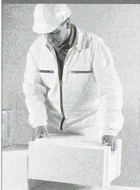
Durch Grifftaschen und das geringe Gewicht ist der PORIT Stein besonders handlich, lässt sich leicht heben und versetzen. PORIT hat ein Doppel-Nut und Feder-Profil. Die Steine können passgenau versetzt werden. Sie sparen sich die Stoßfugenvermörtelung und damit Zeit. PORIT ist massiv, kann jedoch leicht gesägt und bearbeitet werden. Leitungsschlüsse werden gefräst, Schalterdosen gebohrt.
