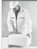
Durch Grifftaschen und das geringe Gewicht ist der PORIT Stein besonders handlich, lässt sich leicht heben und versetzen. PORIT hat ein Doppel-Nut und Feder-Profil. Die Steine können passgenau versetzt werden. Sie sparen sich die Stossfugenvermörtelung und damit Zeit. PORIT ist massiv, kann jedoch leicht gesägt und bearbeitet werden. Leitungsschlitze werden gefräst, Schalterdosen gebohrt.
