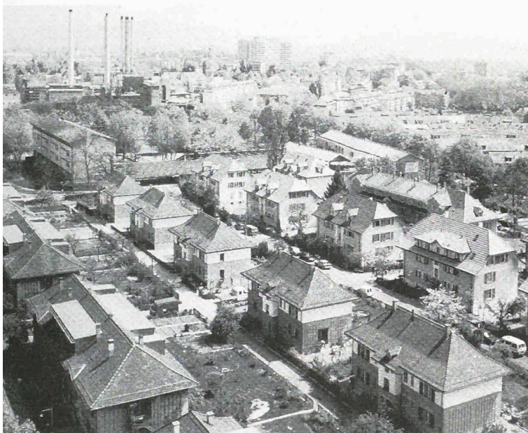
Das Quartier Ausserholligen in Bern wurde sanft saniert, unter Mitwirkung der Bewohnerinnen und Bewohner. Trotzdem sind die Betroffenen nicht zufrieden (Bild aus der besprochenen Broschüre)
