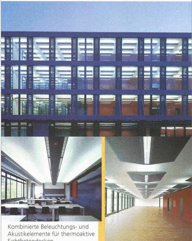
Kombinierte Beleuchtungs- und Akustikelemente für thermoaktive Sichtbetondecken.
