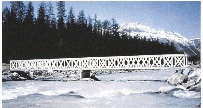
FRP-Brücke Pontresina mit geklebten Verbindungen
