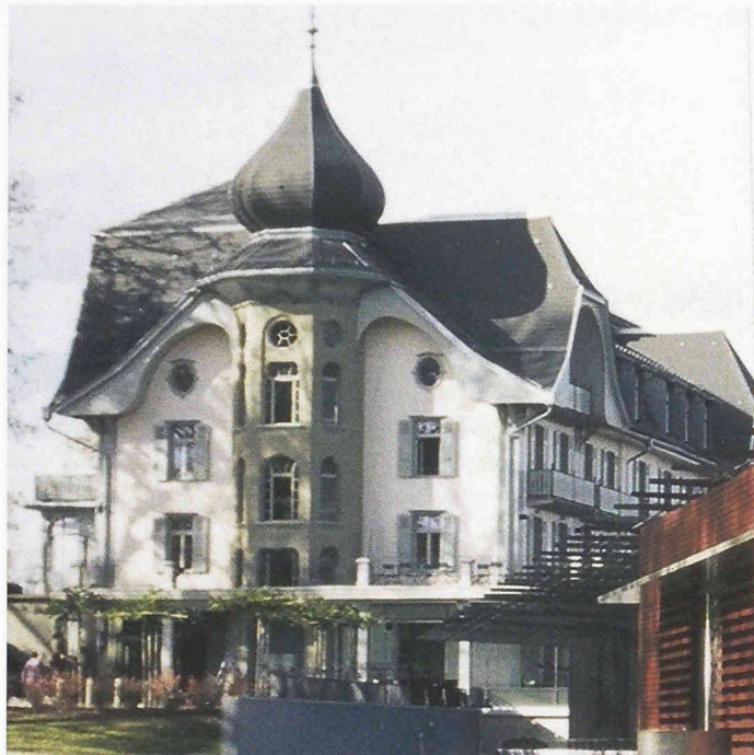
Das ehemalige Kurhotel Gurten-Kulm auf dem Gurten bei Bern ist dank Restaurants und Kulturangebot wieder ein Ausflugsziel. Der geschichtsbewusste Umbau zum Kulturzentrum wurde mit der Auszeichnung «Goldenes Dach» honoriert (Bild: pd)
