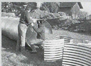
Montage eines HAMCO-Wellstahlrohres in Ermensee, Kt. Luzern.
