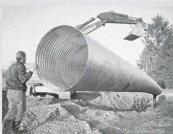
Montage eines HAMCO-Wellstahlrohres in Ermensee, Kt. Luzern.
