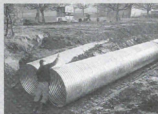
Montage eines HAMCO-Wellstahlrohres in Ermensee, Kt. Luzern.
