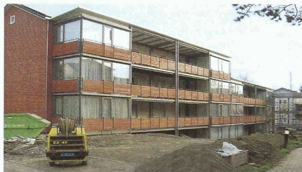
Bild oben: Grundriss nach der Renovation (blau: Küchen/Bäder; gelb: Wohnzimmervergrösserungen, grössere Balkone, Wohnungserweiterung. Bild unten: neue, grössere Balkone
