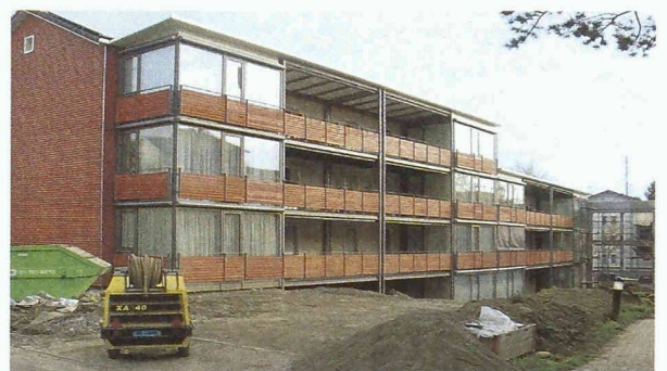
Bild oben: Grundriss nach der Renovation (blau: Küchen/Bäder; gelb: Wohnzimmervergrösserungen, grössere Balkone, Wohnungserweiterung. Bild unten: neue, grössere Balkone
