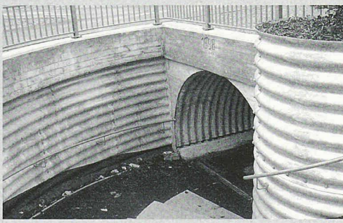
Fuss- und Radweg Unterführung Umfahrung Willisau
